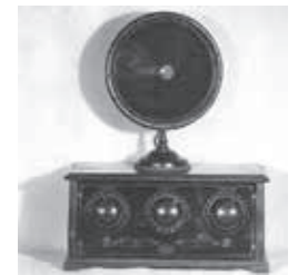
Fig. 24a - ilustração de um radioreceptor operando pelo princípio de radiofrequência sintonizada, marca Airline de fabricação americana por volta de 1925. (coleção Maria de Oliveira)
